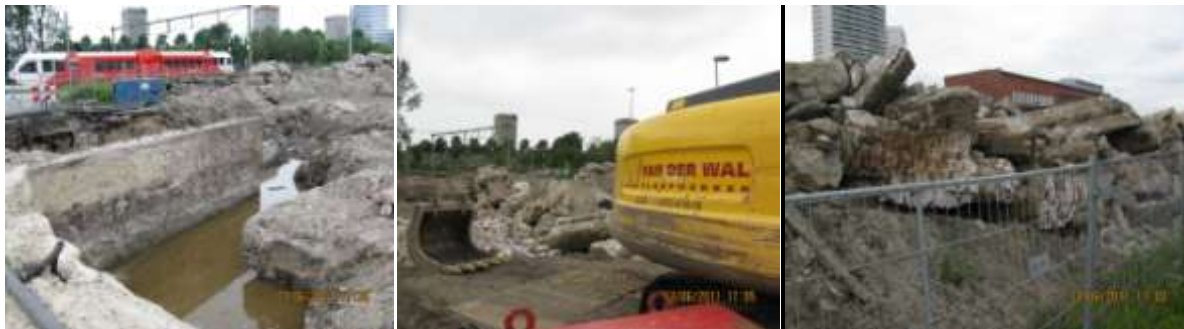
Figuur 17. Het slopen van de rijkste muur van de stad Groningen in het stadsdeel de Linie, mei 2011. Niet alleen verdween hiermee een groeiplaats met 750 Muurvarens (9% van alle Muurvarens), maar ook de enige groeiplaats met Schubvarens.
